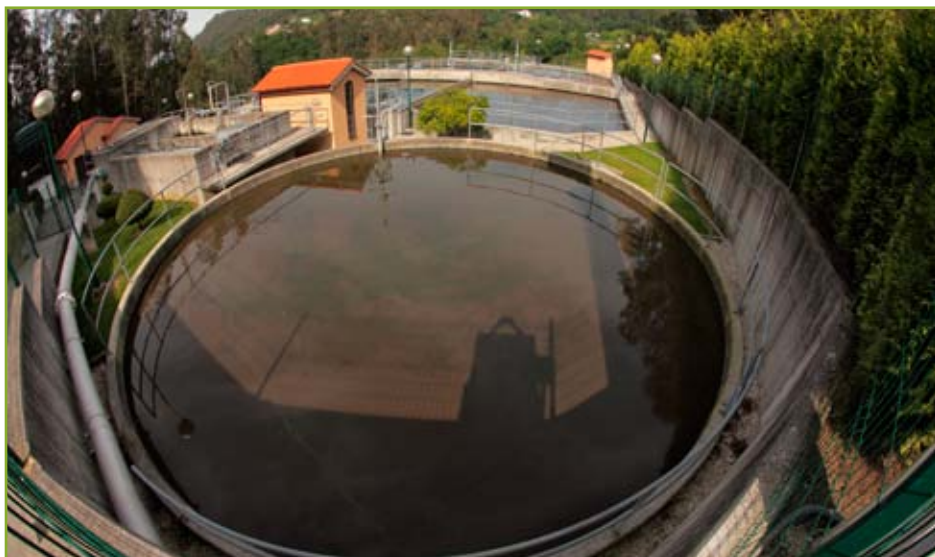
EDAR de Coirós
